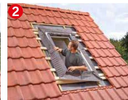
2 Lámina impermeable perimetral BFX
